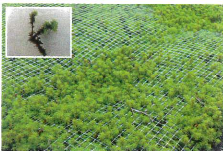
▲上：道路緑地の施工 下：防草・緑化シート
